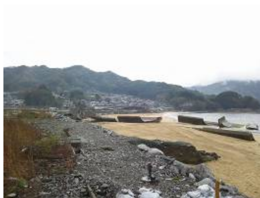
(写真④)吉里吉里地区の海岸。防波堤は各所で破壊され、引き波により海側になぎ倒されている。
