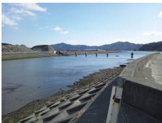
(写真③)大槌川の河口(奥側)。大槌川を遡上した津波は堤防を越えて市街地(右側)を襲った。
