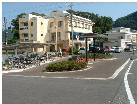
広幅員の歩道
