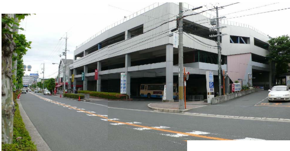
前面道路の西側から見る。この建物の1階がバスターミナルになっている。
