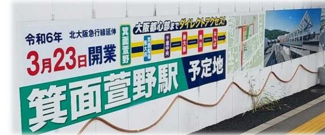
▲ 箕面萱野駅 仮囲い
