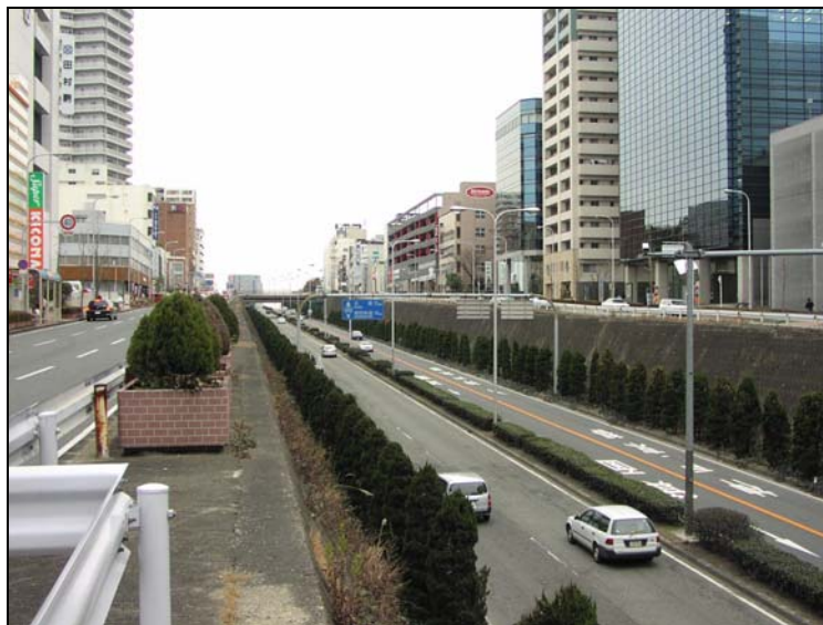
(仮称)箕面船場駅計画地点付近(北 南向き)
