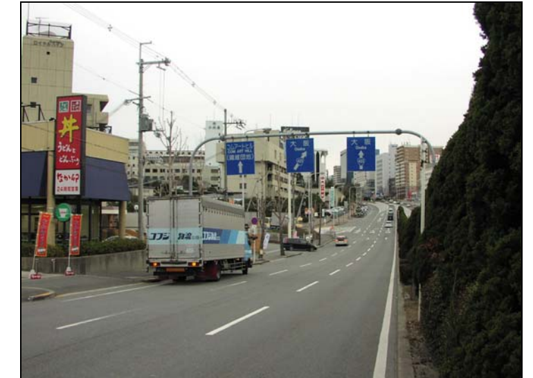
沿線の様子 2 (北 南向き)
