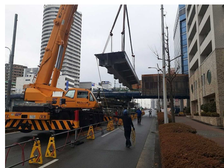
70t ラフター クレーン
