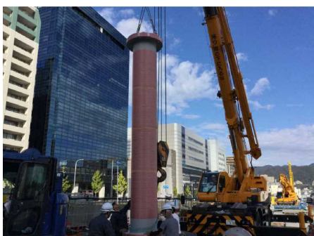
25t ラフター クレーン
